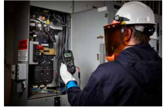
La sonde ampèremétrique flexible en option TA7x ajoute une capacité de mesure du courant CA de 3000 A
